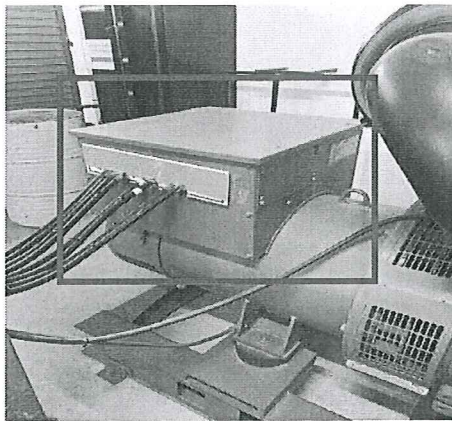
รูปภาพแสดงตำแหน่งติดตั้งและอุปกรณ์ AVR
