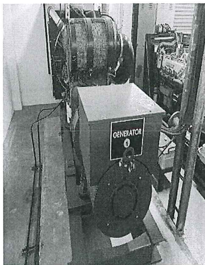
รูปภาพแสดงเครื่องกำเนิดไฟฟ้า ทำงานแบบ AUTO
